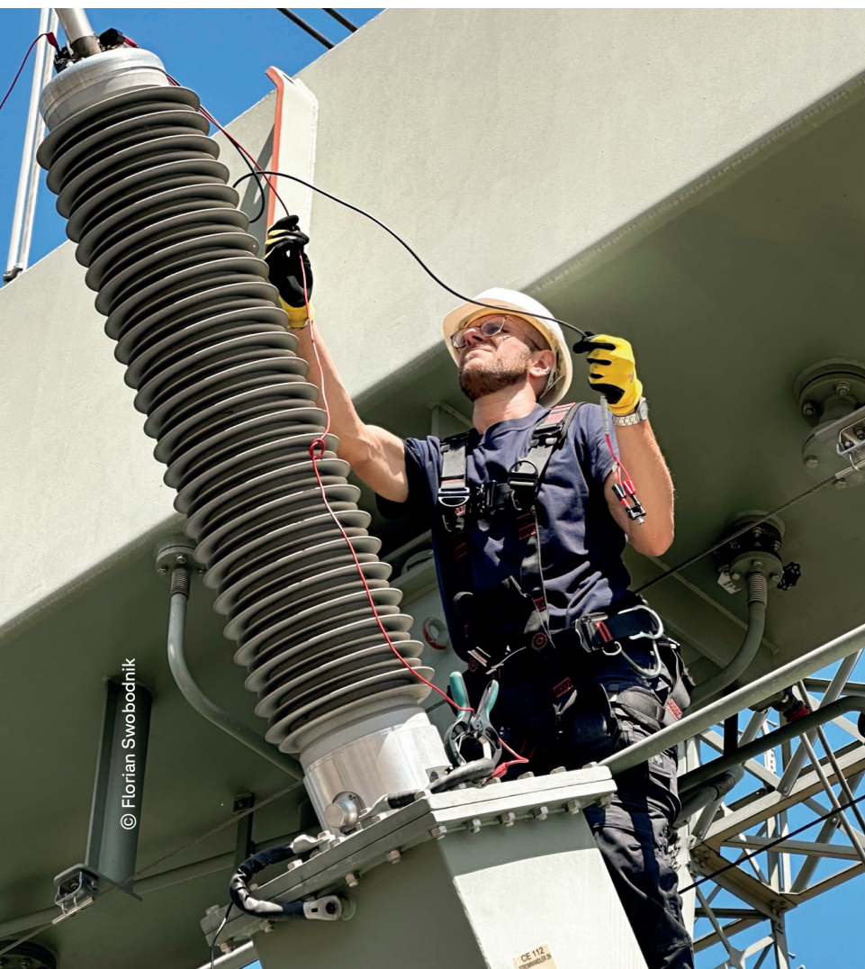
Onsite Diagnose- Messung an einem 380 kV Transformator im Energienetz
